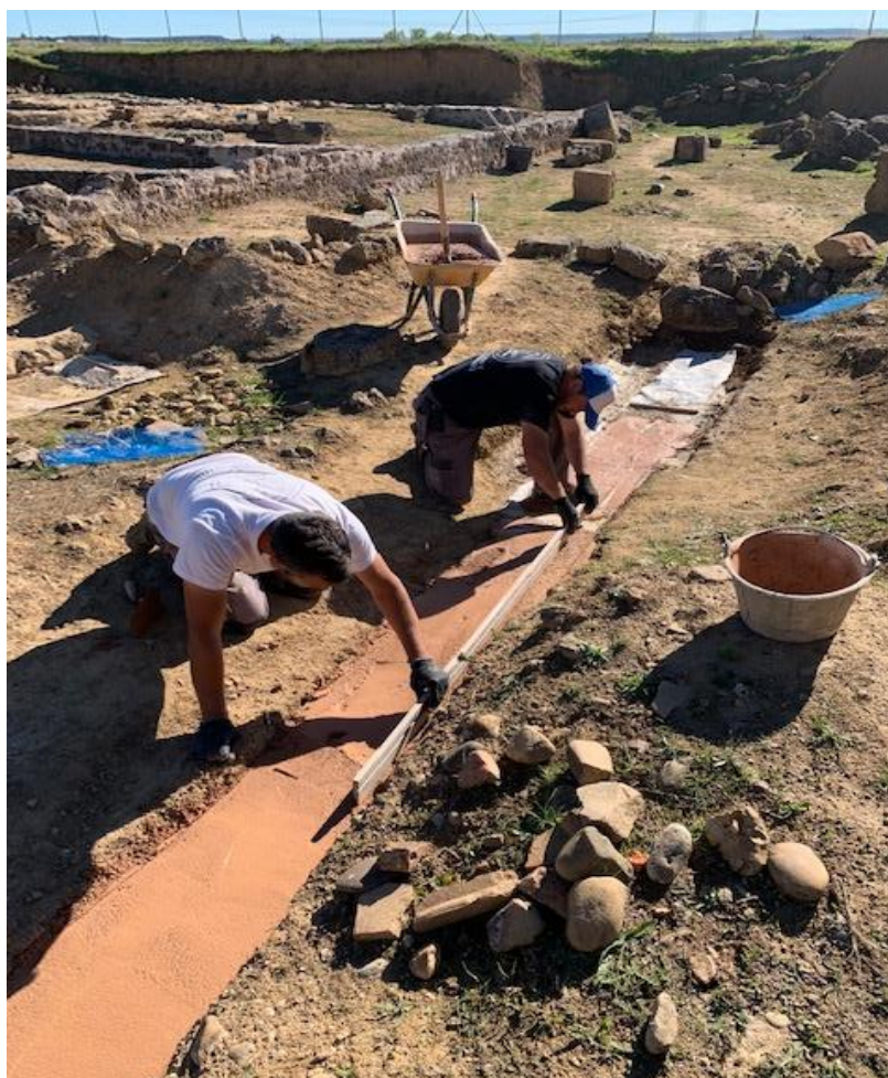
Proceso de cierre preventivo de canalizaciones romanas mediante morteros de sacrificio. Obra de mantenimiento y consolidación de restos arqueológicos en Lancia. Septiembre 2021.
