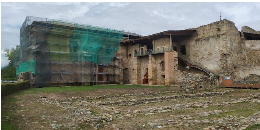
Cillería, refectorio y biblioteca del Monasterio de Sta. María de Carracedo. En proceso de restauración de fábricas y fachadas exteriores.
